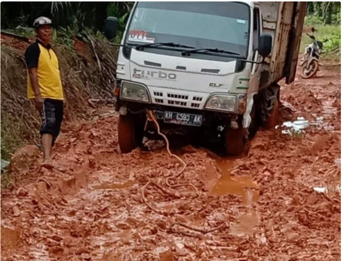
Kondisi Jalan Akses Ke Desa Merah Kecamatan Tualan Hulu, Kotim , Rusak Parah.
