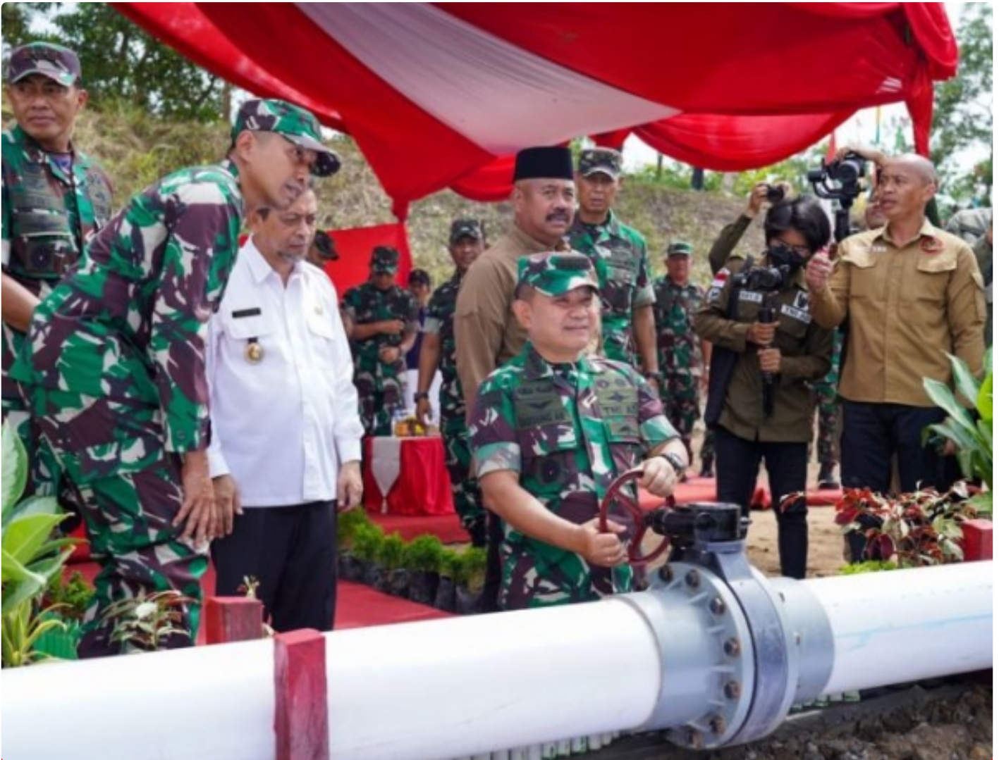
Kasad Jenderal TNI Dr. Dudung Abdurachman meninjau pembangunan irigasi persawahan
